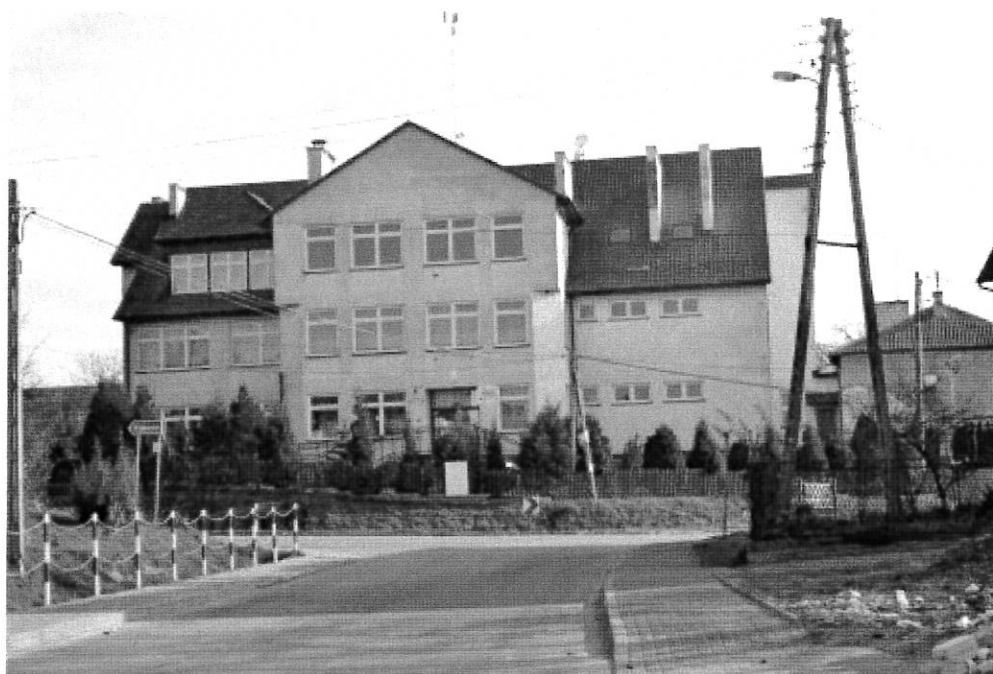
Fot.8 Budynek Szkoły Podstawowej w Porąbkach
