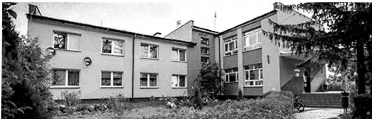
Fot.7 Budynek Szkoły Podstawowej w Makoszynie
