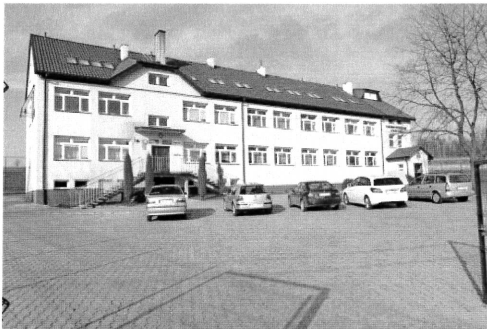
Fot.2 Budynek Zespołu Placówek Oświatowych w Hucie Starej
