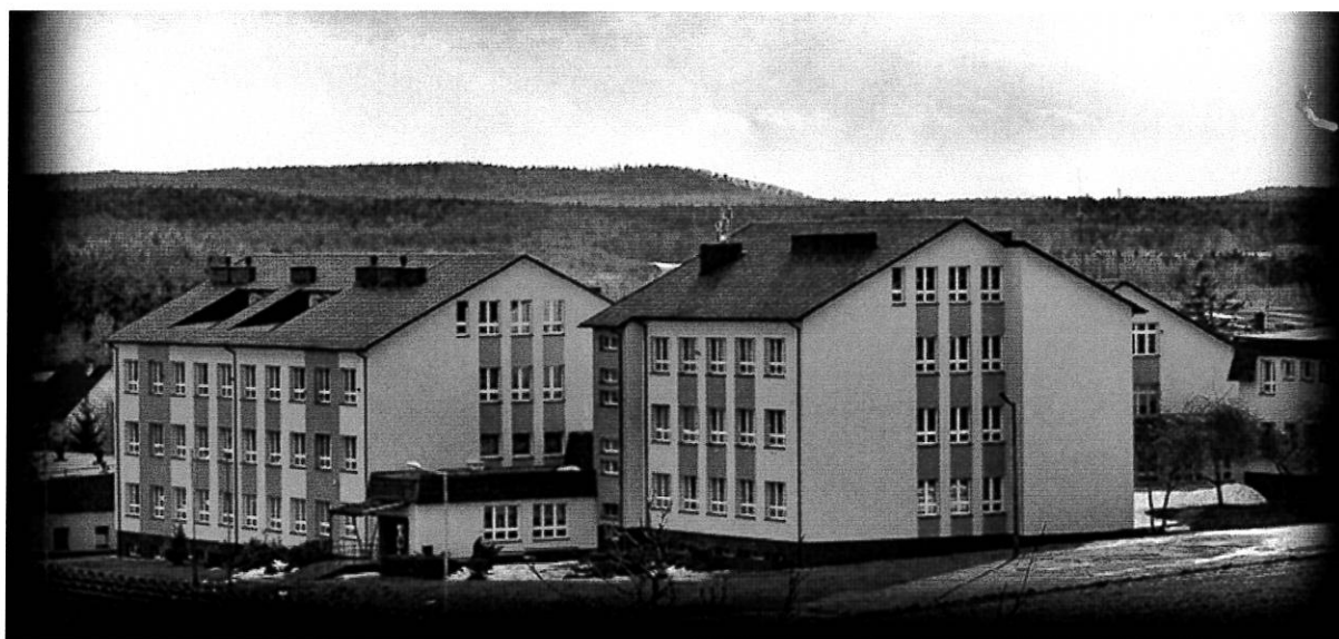
Fot.1 Budynek Zespołu Szkół Samorządowych w Bielinach
