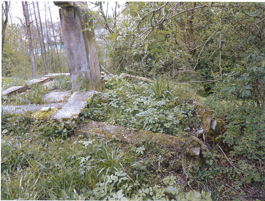
fot. nr 7 - Murek wokół tablicy – widok od strony zachodniej.
